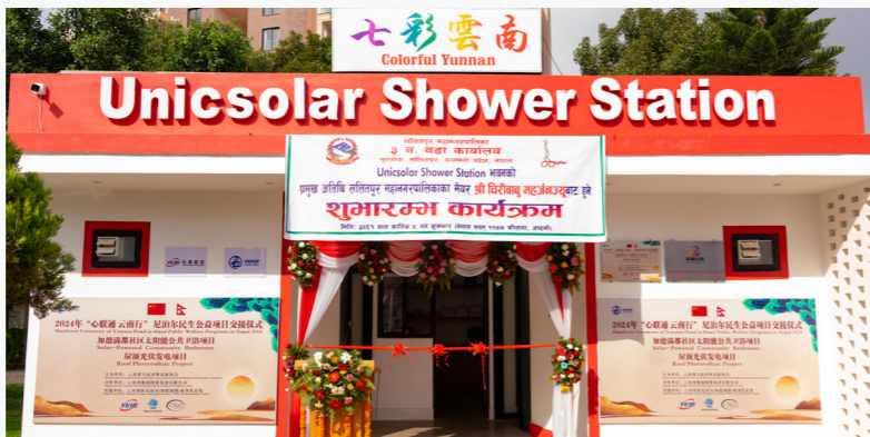
尼泊尔太阳能公共卫浴项目
