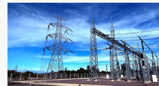
老挝班哈—班纳—阿速坡 500 千伏输变电项目
