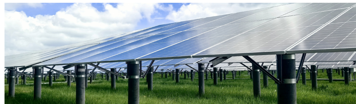
曲靖发电公司贮灰场生态环境综合治理光伏项目实现“板上发电”“板下复绿”
