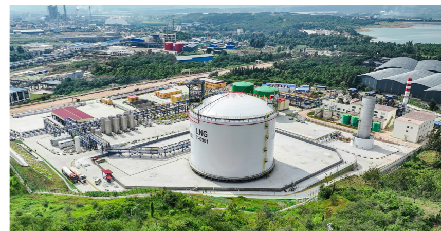
曲靖应急气源储备中心
